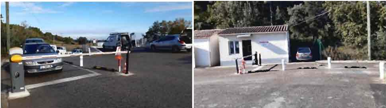
Figure 7 : Photographies du local gardien à l'entrée de la déchèterie et de la barrière de contrôle (Cereq, visite du 28/10/2020)
