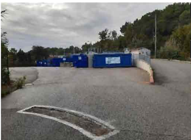
Vue de la déchèterie depuis son entrée
