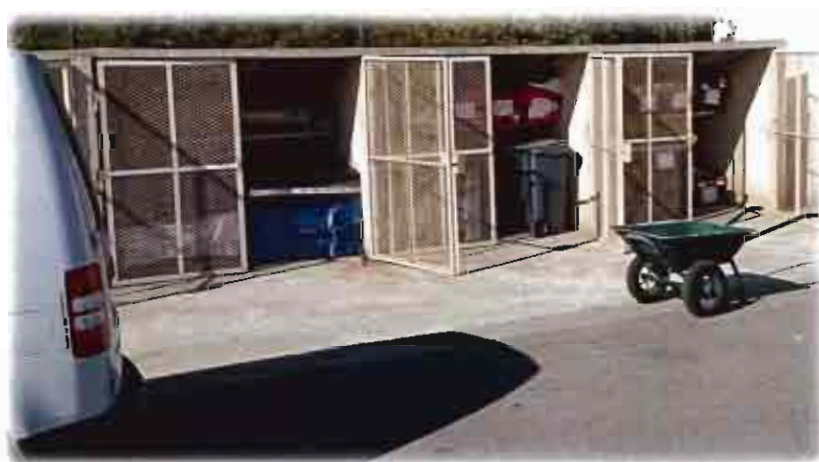
Local DDS existant ne répondant plus aux normes
